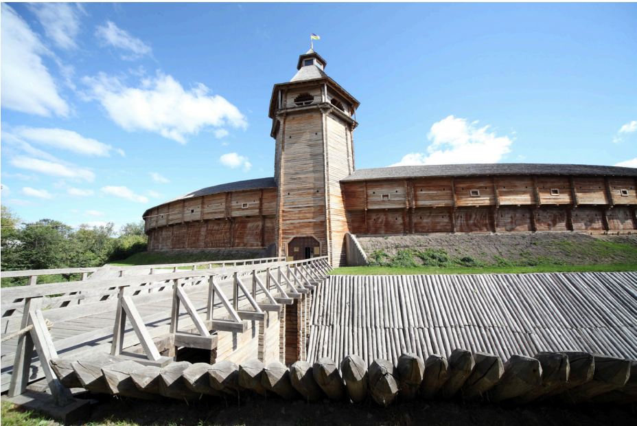
Рів з мостом, вал зі зрубною стіною та вежа з брамою цитаделі Батурина. Реконструйовано на основі археологічних даних у 2008 р.
