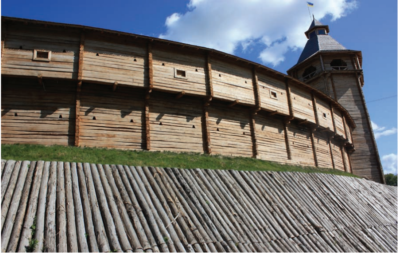
Зрубні стіни і надбрамна вежа на валі та замощений колодами рів цитаделі батуринської фортеці XVII ст. Реконструкція 2008 р. Світлина споруд цитаделі В. Мезенцева.
